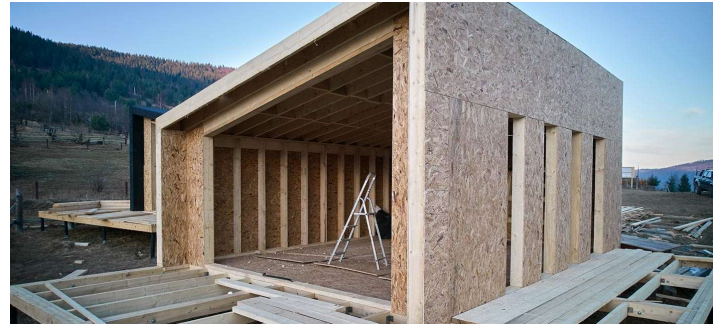
Figure 3: OSB utilisé dans un bâtiment
